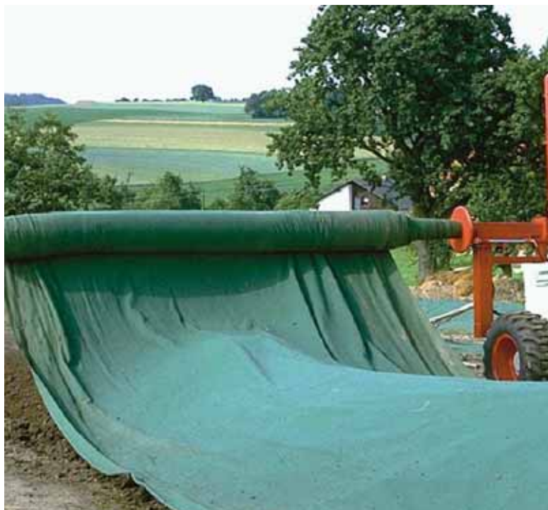
Photographie 4 : Mise en place d'un géo-textile Top-Tex sur un andain après le dernier retournement ( Source : www.baches-gangloff.fr ).
